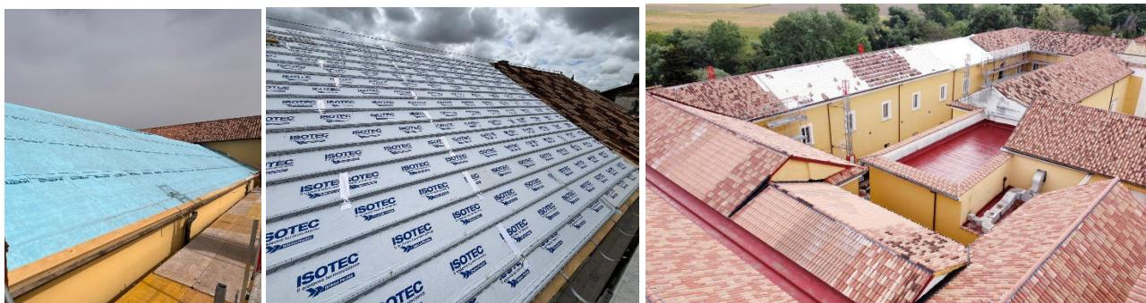
Il rivestimento superiore e inferiore del pannello in lamina di alluminio svolge un'efficace funzione di **seconda impermeabilizzazione**, proteggendo sia l'isolante stesso, che la struttura sottostante in caso di infiltrazioni accidentali. Il sistema Isotec è leggero, facile da manovrare e da lavorare in quota con comuni strumenti di
