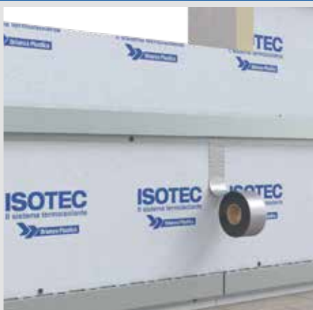
7 - Sigillatura dei giunti
